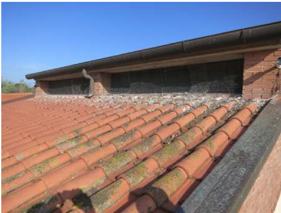
Bild 1. Süd-Dach vor Reinigung und vor dem Einsatz.
