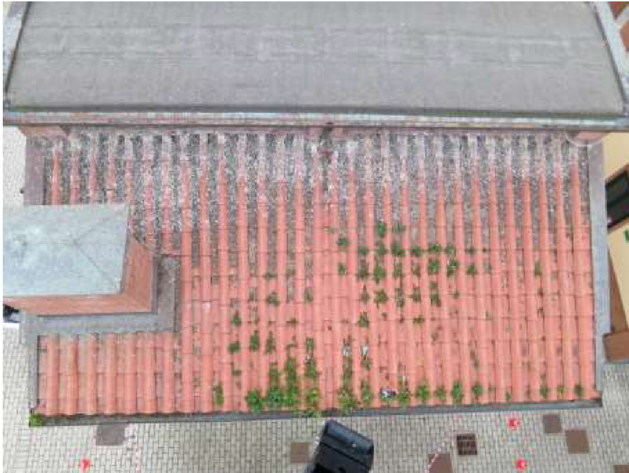
Bild 6. Nord-Dach vor Reinigung und Einsatz.
