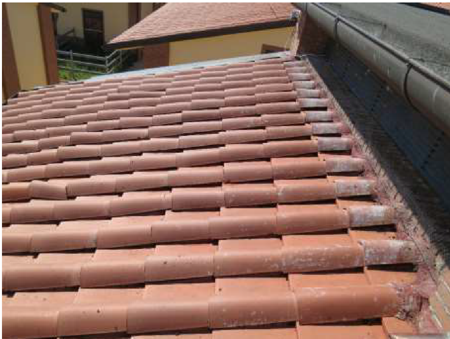
Bild 3. Süd-Dach nach der Reinigung.
