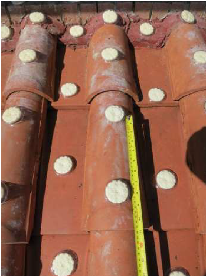
Bild 4. Auf dem Süd-Dach wurde Bird Free eingesetzt.
